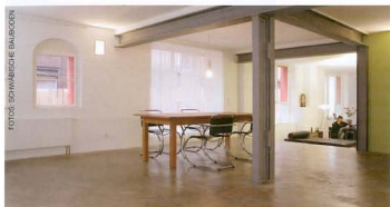
...und durch eine Stahlskelettkonstruktion ersetzt. Die Wandgestaltung...
