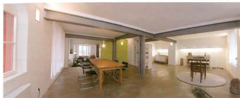
Vier Loftwohnungen in Stuttgart: Die innere Tragstruktur wurde entfernt ...
